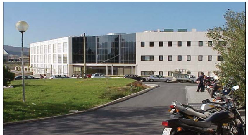
En la imagen, instalaciones que acogerán la sede del Congreso.
